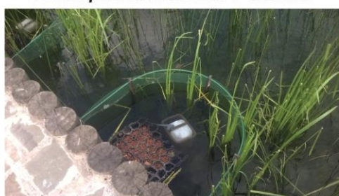
Работа Оксидатора W maxi в зоне растительной очистки.
